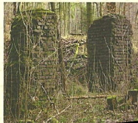
Alaunhütte III: Bauliche Reste des Kamin
